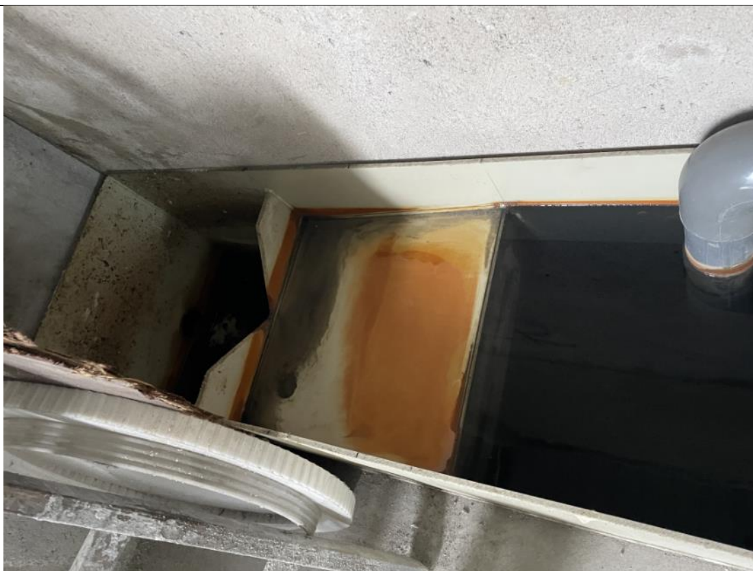
图 4.3-5 生产废水排放口
