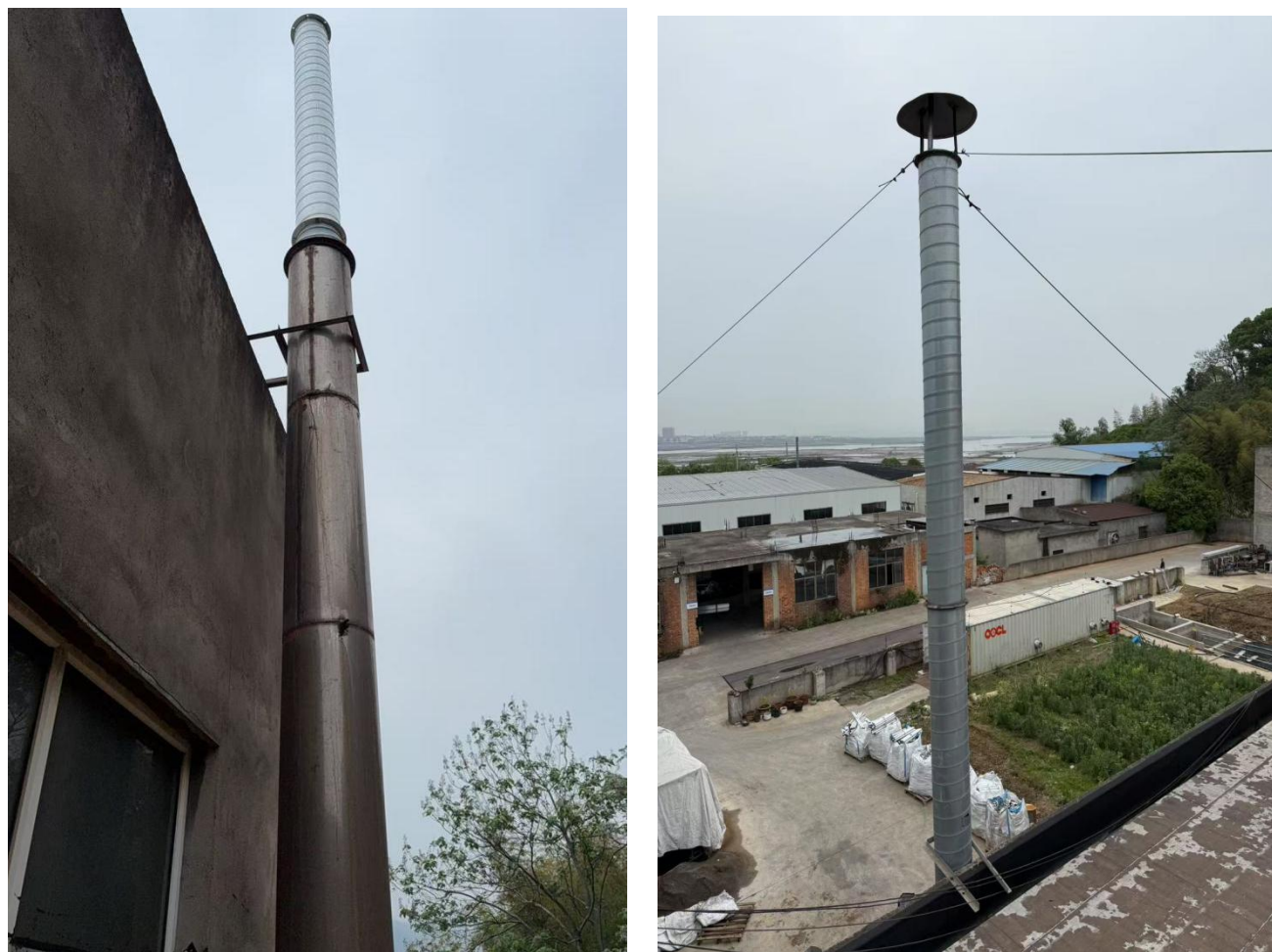
图4.3-1 天然气燃烧废气收集设施示意图
