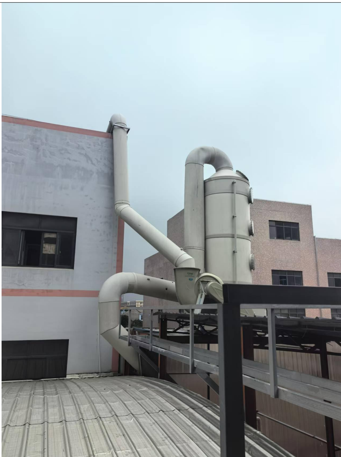
图4.3-2酸洗废气处理设施示意图
