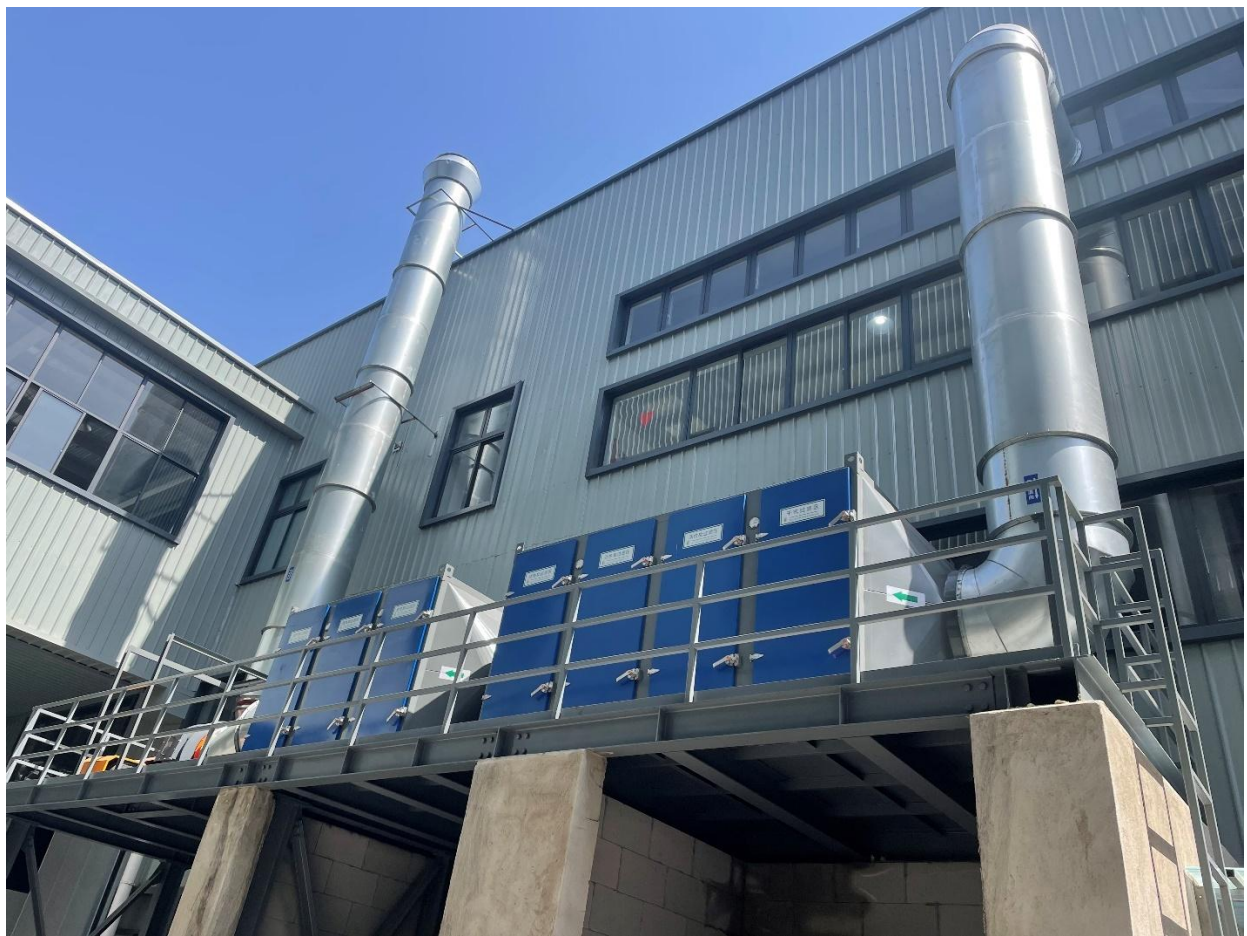
图 4.3-1 有机废气处理设施示意图
