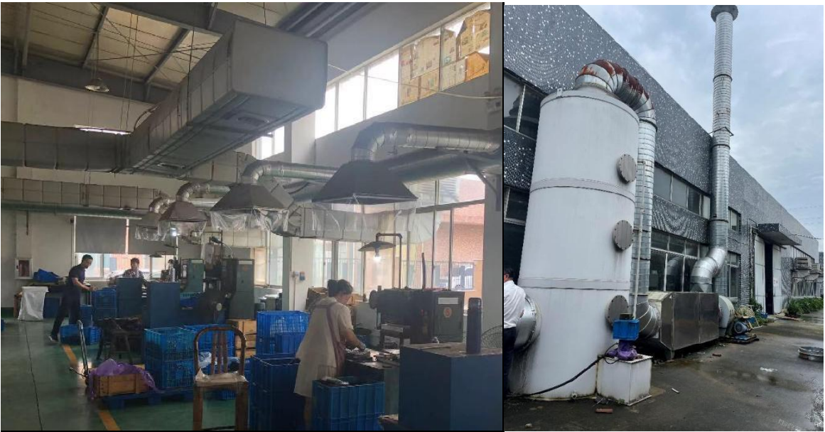
图4.3-1 硫化废气处理设施示意图
