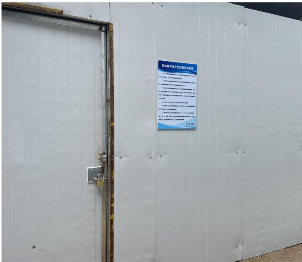
图 4.1-2 一般工业固废暂存间照片
