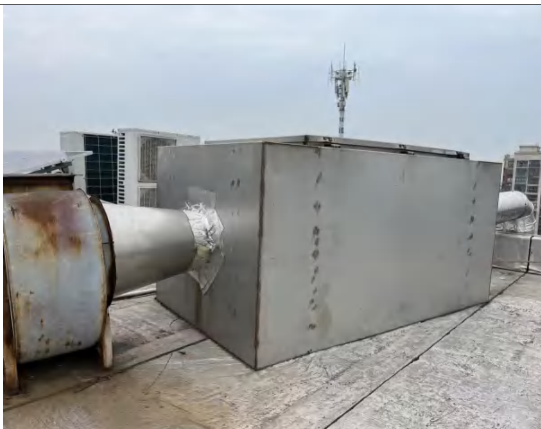
手动喷漆+烘箱+粘磁钢废气处理设施（活性炭吸附）
