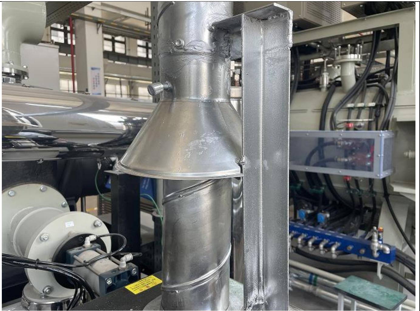
图 3.1-2 真空泵尾气收集装置示意图
