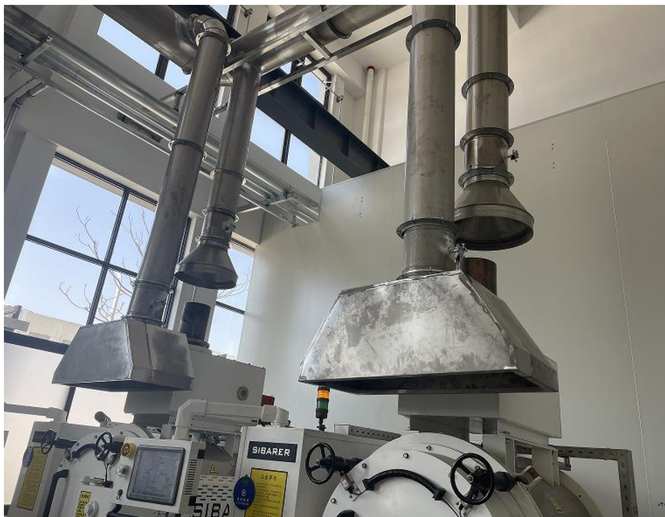
图 3.1-1 脱脂废气收集装置示意图
