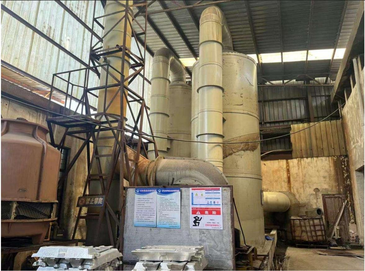
酸雾废气治理设施（铝氧化生产线）
