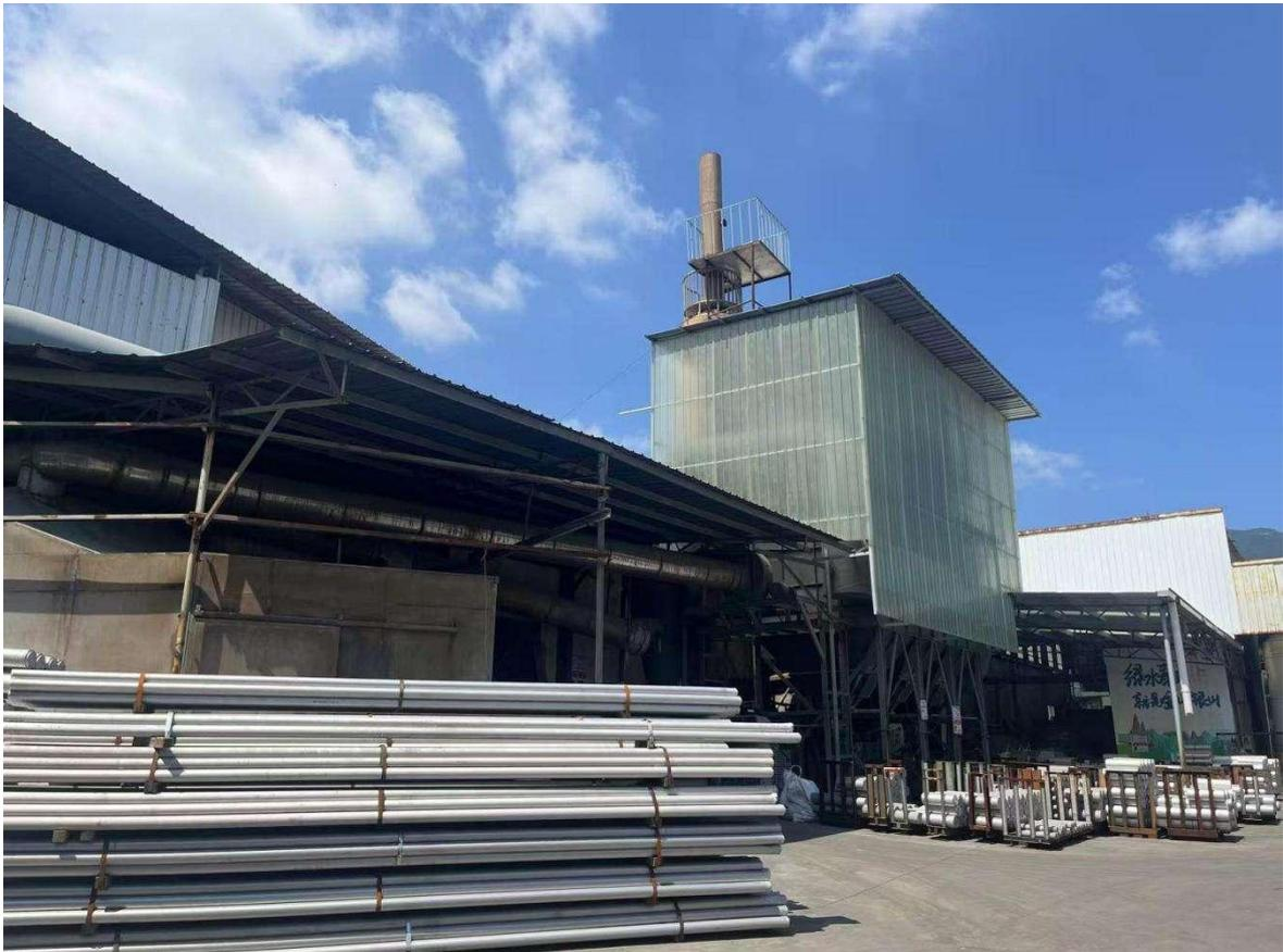
铸造废气（熔炼炉）、熔化废气（熔炼炉）、燃料废气（熔炼炉）治理设施
