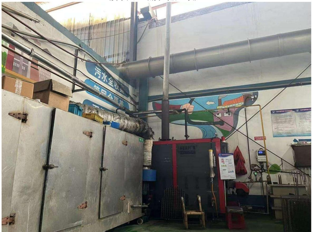
天然气燃烧废气（铝氧化生产线锅炉）治理设施
