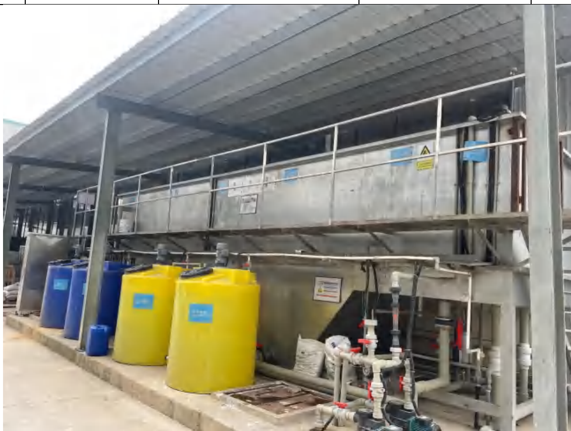
图 3.1-17 生产废水处理设施
