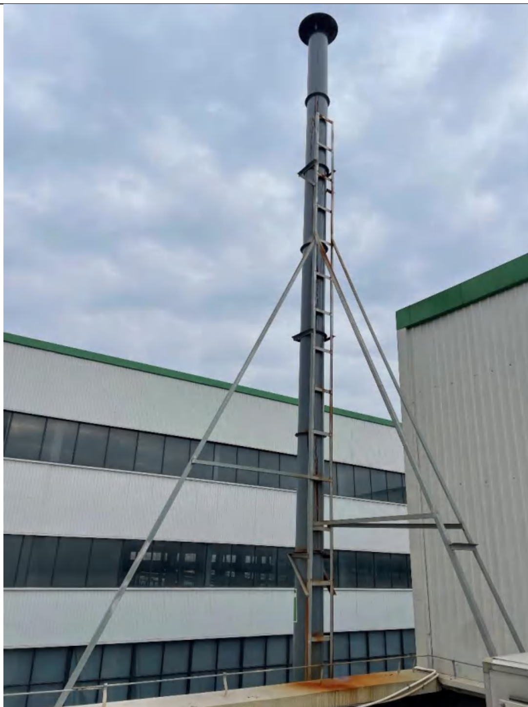
图3.1-13 天然气燃烧废气处理设施示意图
