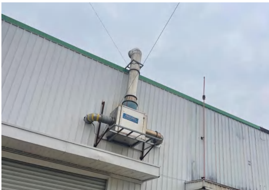
图3.1-3 2#车间热处理炉天然气燃烧废气处理设施示意图
