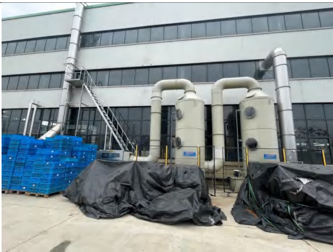
图3.1-11 熔化、铸造废气处理设施示意图
