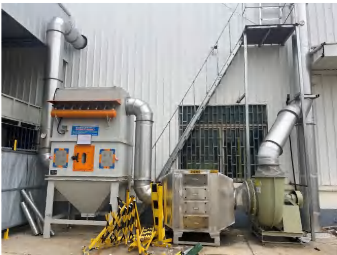
图3.1-2 制芯、震砂废气处理设施示意图
