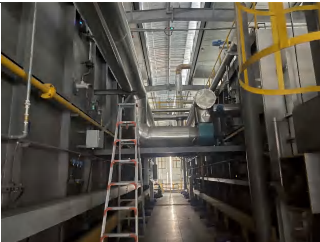
图3.1-6 4#车间热处理线天然气燃烧废气处理设施示意图
