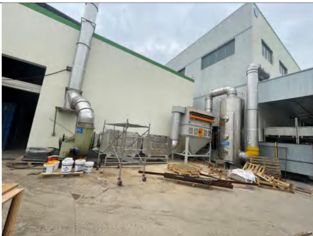
图3.1-4 熔化废气、铸造废气处理设施示意图
