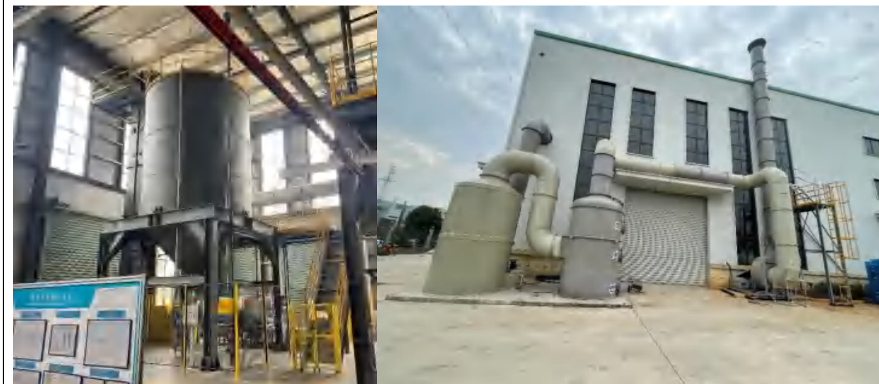
图3.1-10 制芯废气处理设施示意图
