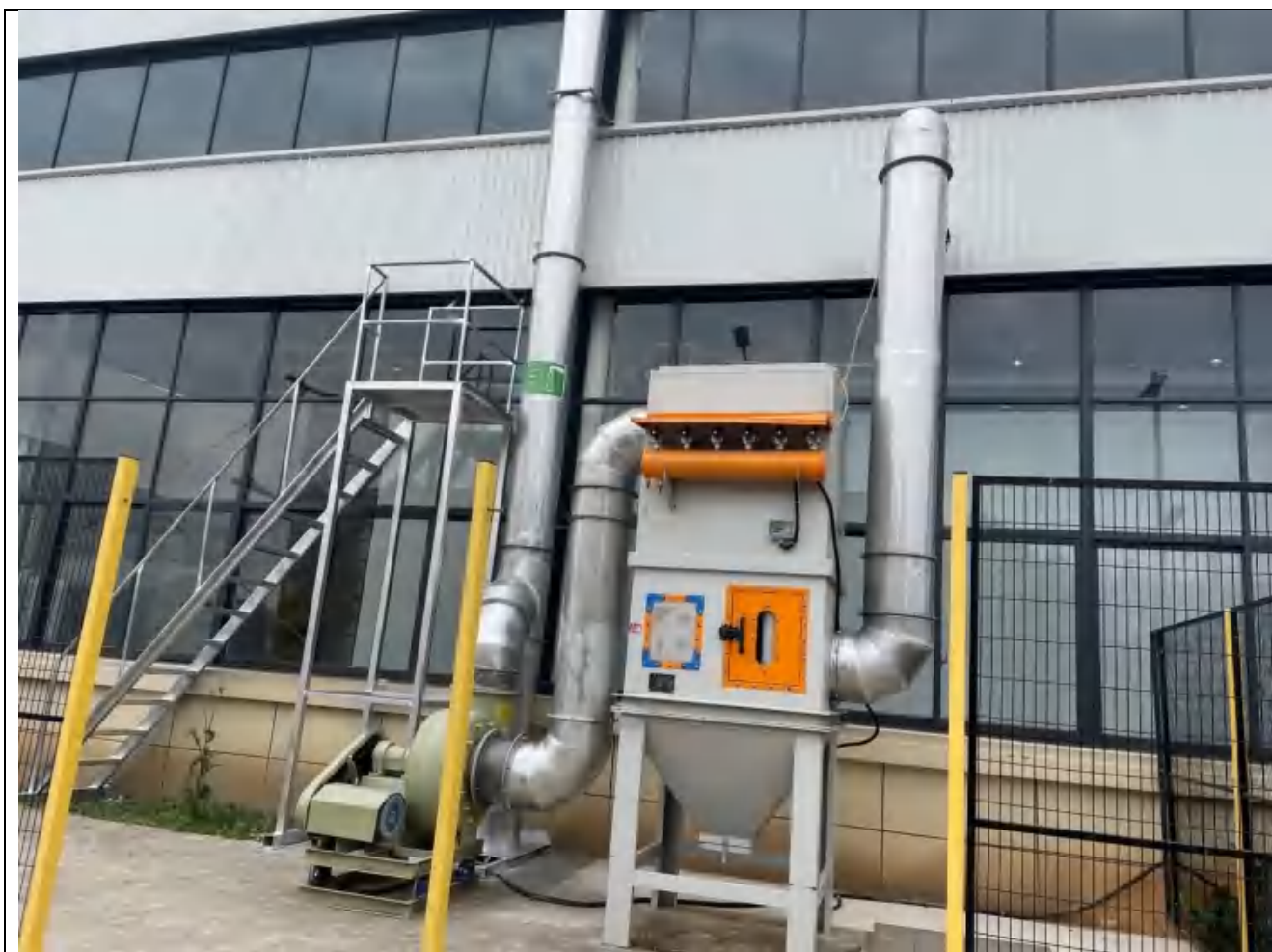
图3.1-9 震砂废气处理设施示意图
