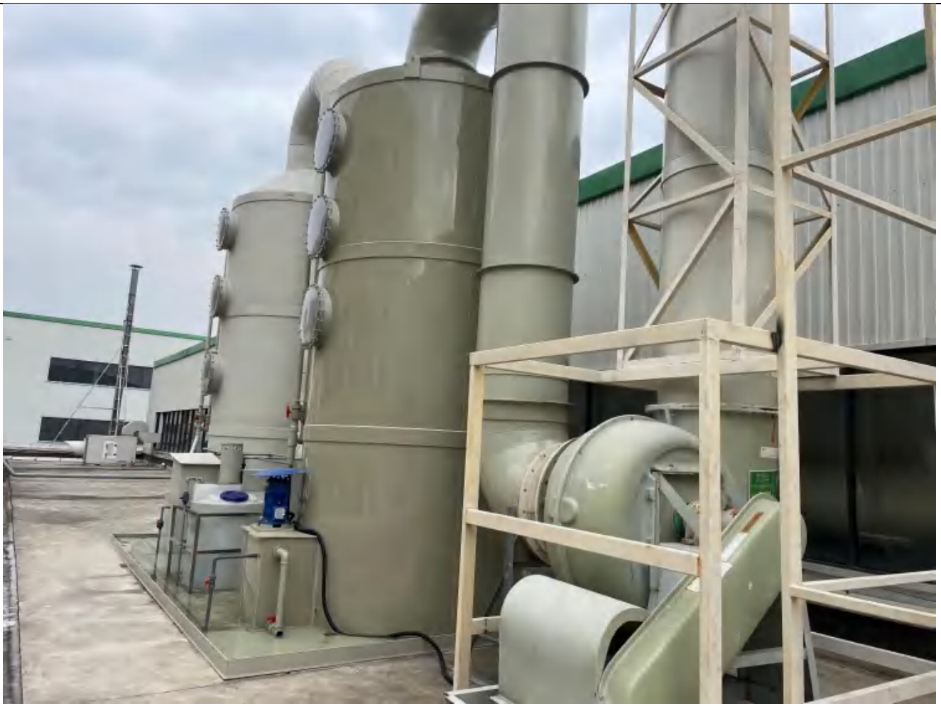
图3.1-12 中和废气处理设施示意图
